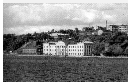
Это здание ранее входило в состав пивоваренного завода, ныне - индустриальный техникум.
